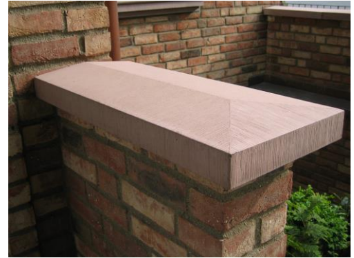
MPU Endstück mit einseitig geneigtem Ende, durchgefärbt toskana-rot
